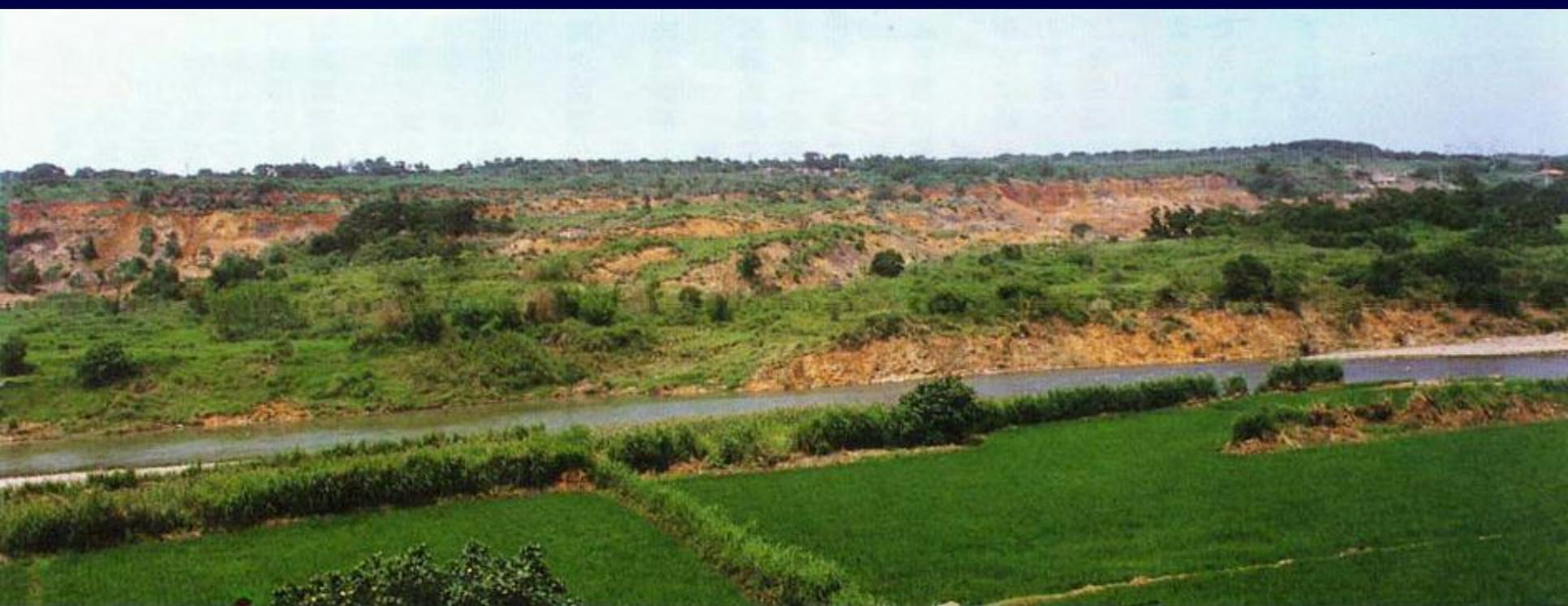
1990年4月23日在一場暴雨後，新竹縣新埔鄉在距國道一號約三百公尺外的鳳山溪北側山坡發生大規模地層順層滑動，面積達**20**公頃，幸未造成傷亡。此地屬更新世楊梅層，地層傾角僅約**5**度，但因河流掏蝕坡腳，加以台地邊緣容易滲出地下水而致滑動面水壓激升，終致滑動。
