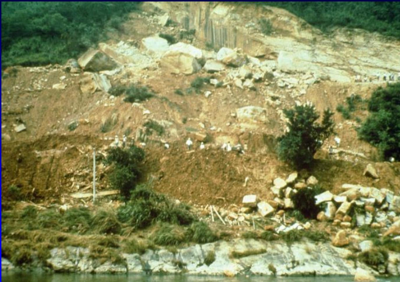
1974年9月28日，興建中的中山高速公路八堵交流道因順向坡坡腳被挖除，施工中即發生地層滑動(南港砂岩)，數萬方土石埋沒基隆河右岸的十數間民宅，造成36死之悲劇。
